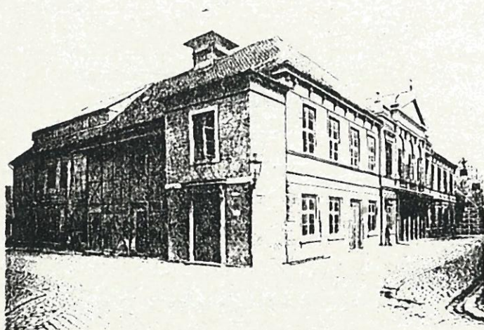
Den gamle teaterbygning på Sortebrødre Torv fotograferet 1915, året efter teatrets lukning. Hovedindgangen lå i Theater- stræde til højre i billedet. Det er overstræde til venstre (Montergården).
